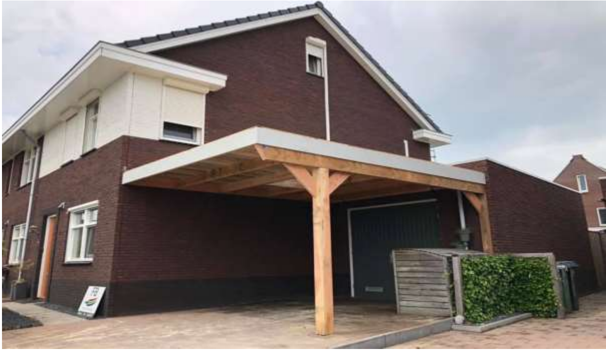
Carport met hardhouten voorgegronde dakrand
