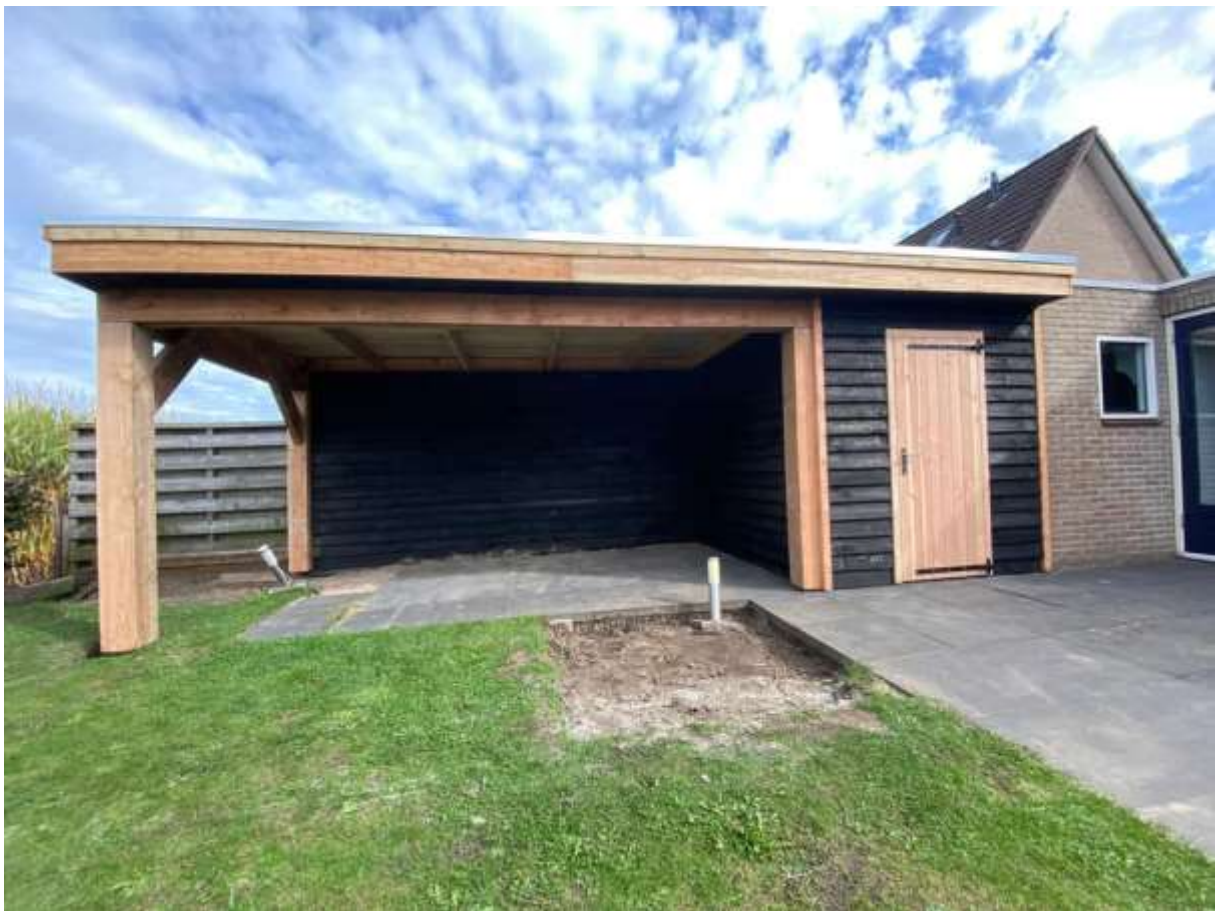
Veranda 3,5x7 meter, met aan 1 zijde een schuurtje. Een project als deze wordt op de dag zelf op locatie op maat gemaakt aansluitend op de bestaande bebouwing.
