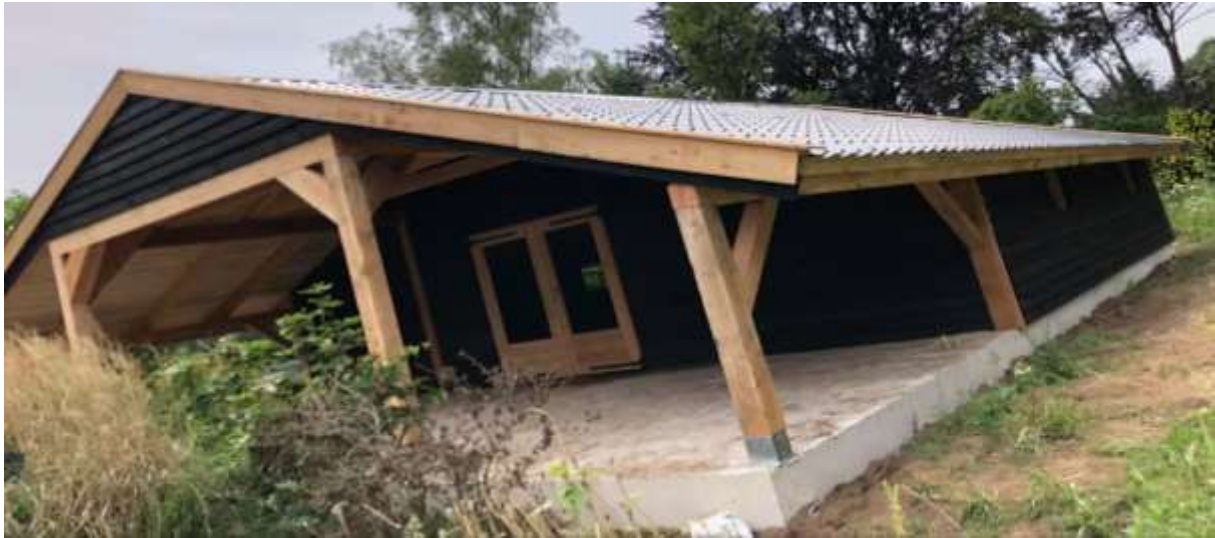
Apres ski hut 14x20 meter, voorzien van onze stalen dakpanplaten.
