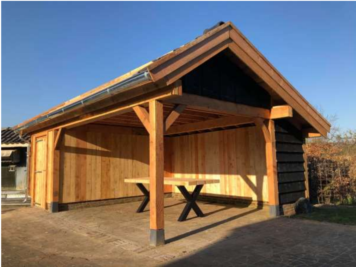
Kapschuur 6x8 meter. Deze constructie kan voorzien worden van stalen dakpanplaten of pannen naar wens.
